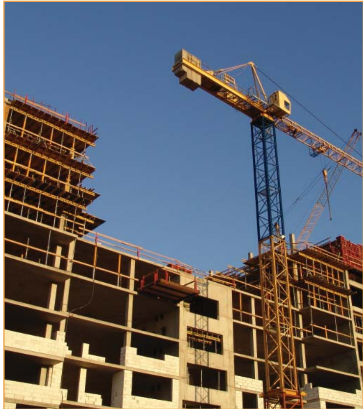
Edificios de viviendas en construcción
