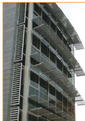
Edificio bioclimático Trasluz
