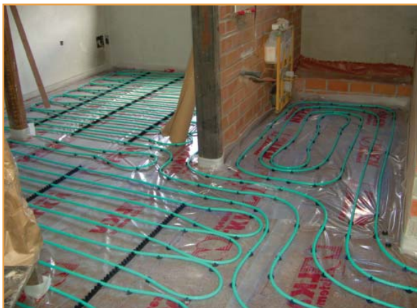
Instalación de suelo radiante
