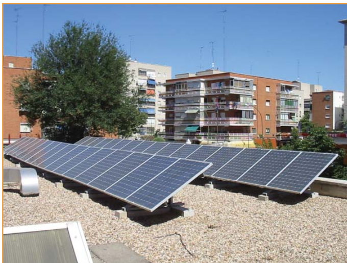
Instalación de paneles solares fotovoltaicos
