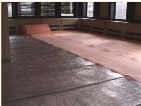
Aislamiento en suelo con polietileno reticulado
