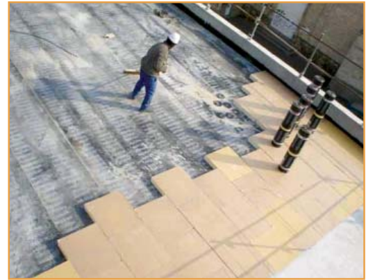
Rehabilitación de cubierta por el exterior
