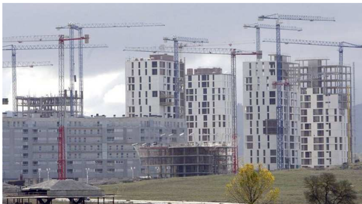
Sentencia de las cláusulas suelo. Un obrero trabaja en un bloque de viviendas en construcción./ AP ATLAS
